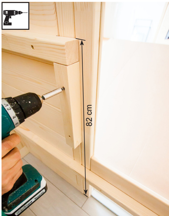
3 parafusos de 5 x 70 mm 2 parafusos de 4 x 60 mm
