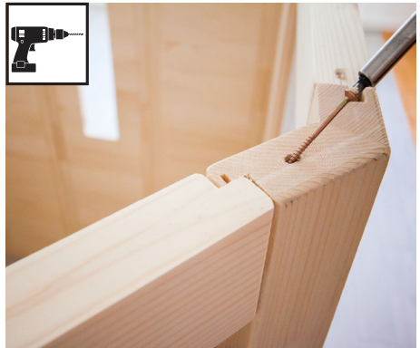
Bohrer 3 mm, 1 Stk. Schrauben 4 x 70 mm
