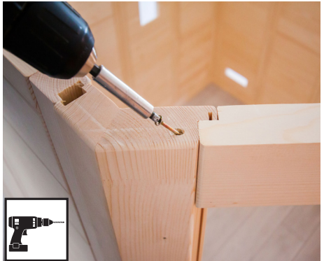
Bohrer 3 mm, 1 Stk. Schrauben 4 x 70 mm
