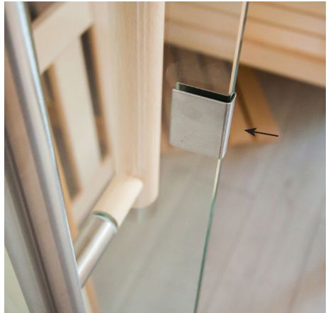
Kunststoff Beilagscheibe bei Niro-Griff beilegen
