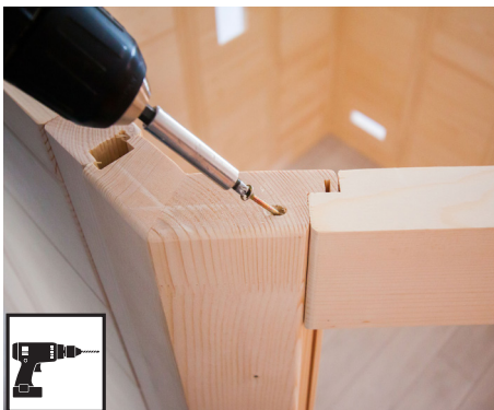
Broca de 3 mm, 1 parafuso de 4 x 70 mm
