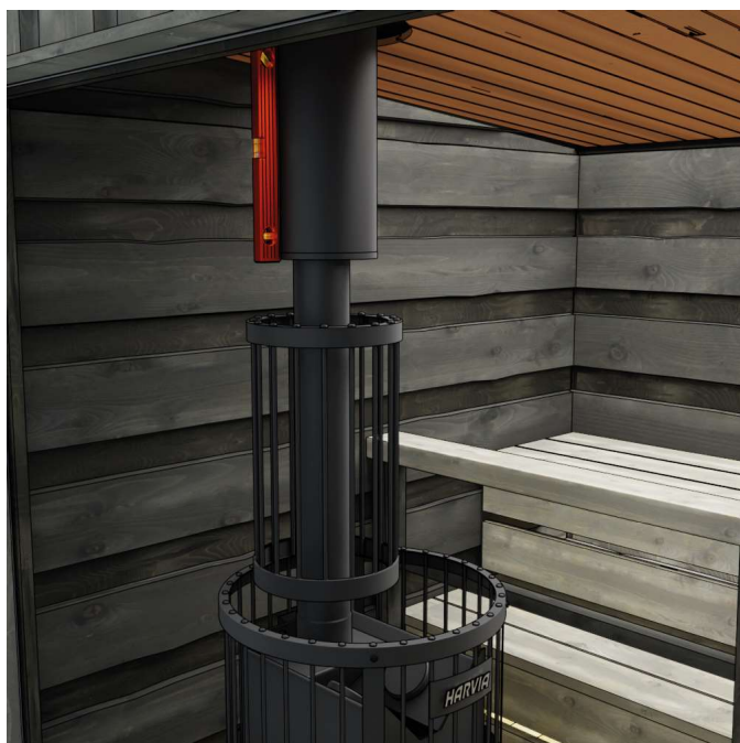
13. Vérifiez la rectitude de la cheminée. Déplacez le poêle si nécessaire.
